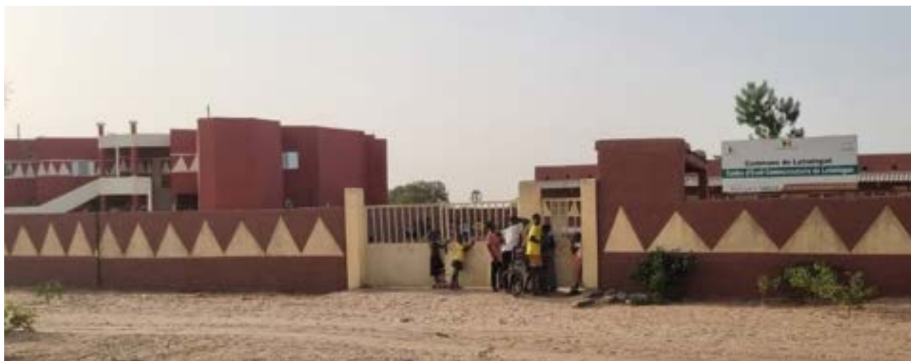
Photo 6 : Bâtiment administratif à Latmingué
