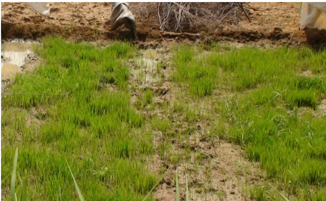
Pépinière à la volée au niveau du site de Décolle
