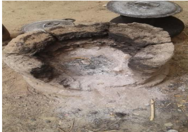
Photo 14 : Fourneau amélioré en état de délabrement
