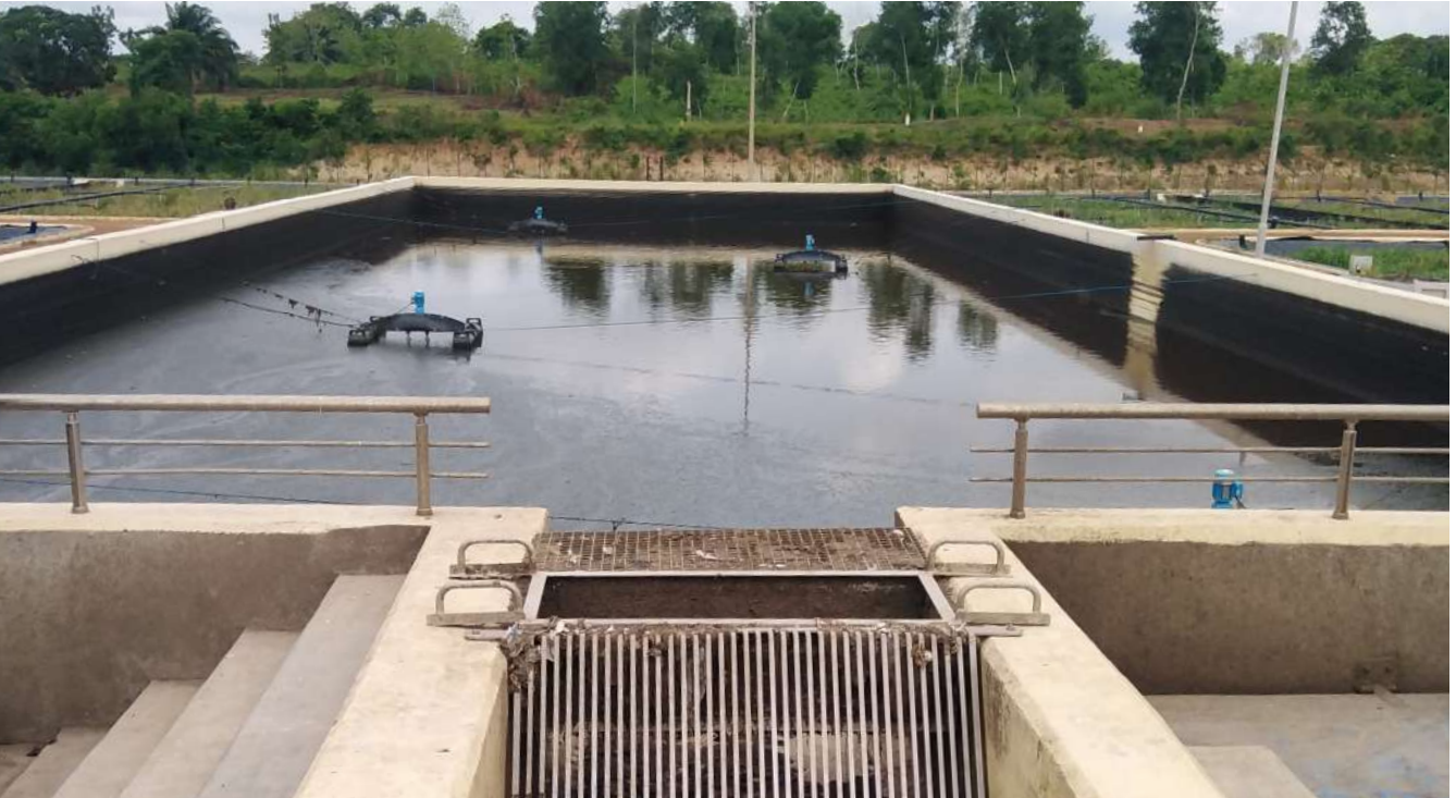
Usine de traitement des eaux usées au Bénin.
